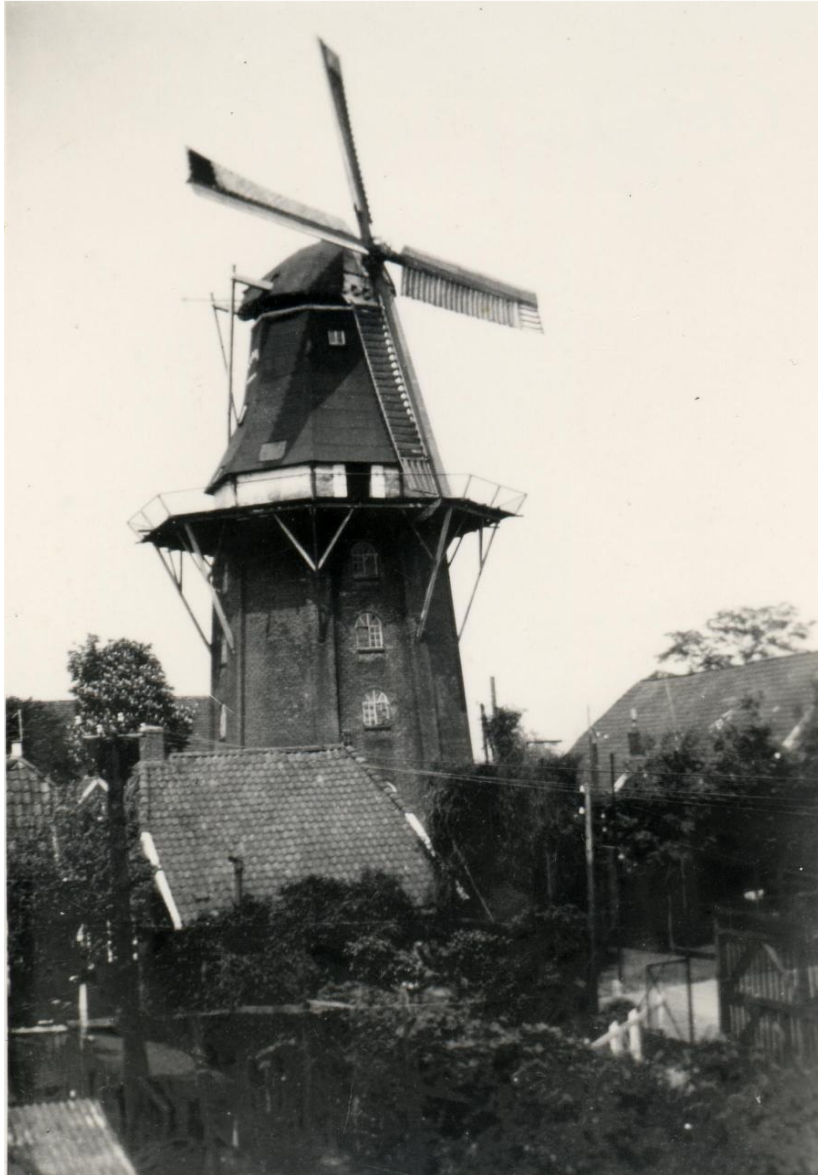
Koren- en pelmolen "Aurora" te Noordbroek vóór 1942. Dit was de hoogste molen van Groningen. De stellinghoogte bedroeg 16 meter. Foto: WO. Bakker.
