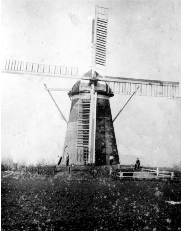
De molen te Borgercompagnie gefotografeerd in de twintiger jaren van de vorige eeuw. Het gevluht is voorzien van zelfzwichting, met op de binnenroede korte remkleppen, haaks op de zelfzwichting. De vlucht bedroeg 23,50 m.
