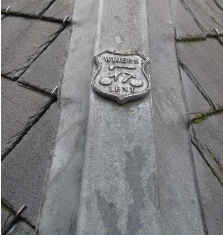
← Hoekkeperafdekking met loodbevestiging, vastgezet met spijkers en afgedekt met een trotseerloodje.
