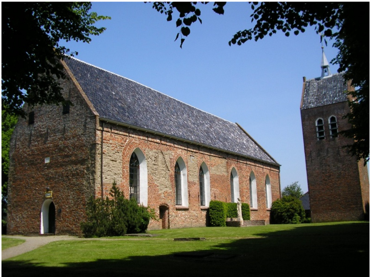
Het eenbeukig kerkgebouw met de vrijstaande toren. Foto: http://reliwiki.nl .
