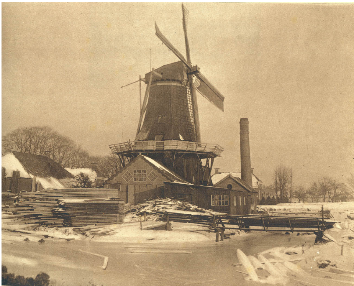
Het zaagmolencomplex van Wilte Evenhuis te Woltersum, gefotografeerd in 1928, met aan de rechterzijde de aanbouw voor de lintzaag en het gebouwtje met de pijp voor de stoommachine.
