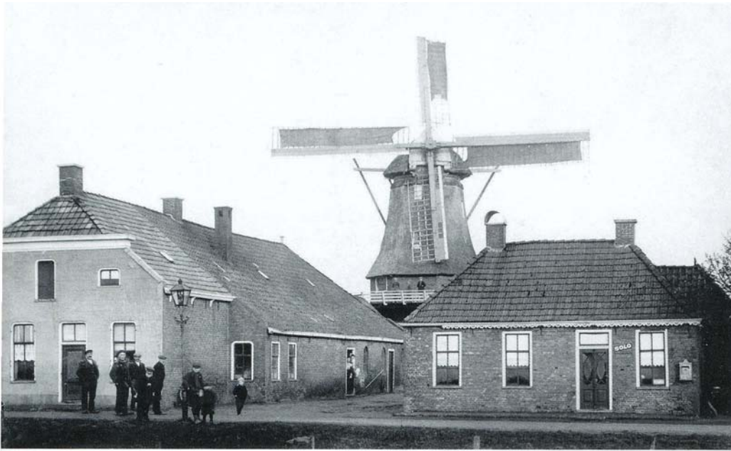
▲ AFB. 4. DE MOLEN TE VALOM MET OUDHOLLANDS GEVLUCHT, EEN KORTE HOUTEN BINNENROEDE EN EEN IJZEREN AS. OPNAME OMSTREEKS 1920. (FOTO COLLECTIE B.D. POPPEN)
